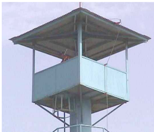
Foto 15.3. – Torre de Seguridad del Perímetro
